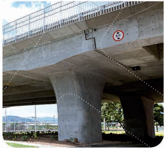
Puente Itagüí - conexión Sabaneta
